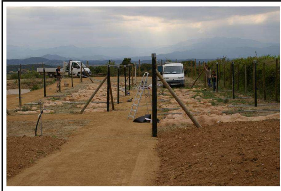
**Figura 13.** Construcción de la estructura base de postes de madera torneados. Fuente: ATA.
