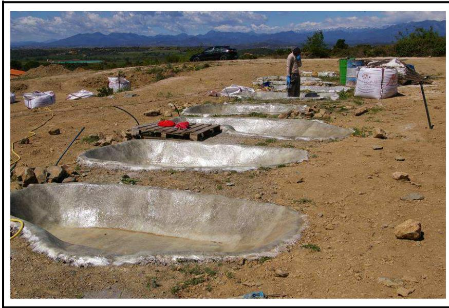
**Figura 9.** Construcción pequeñas lagunas, colocación de poliéster. Fuente: ATA
