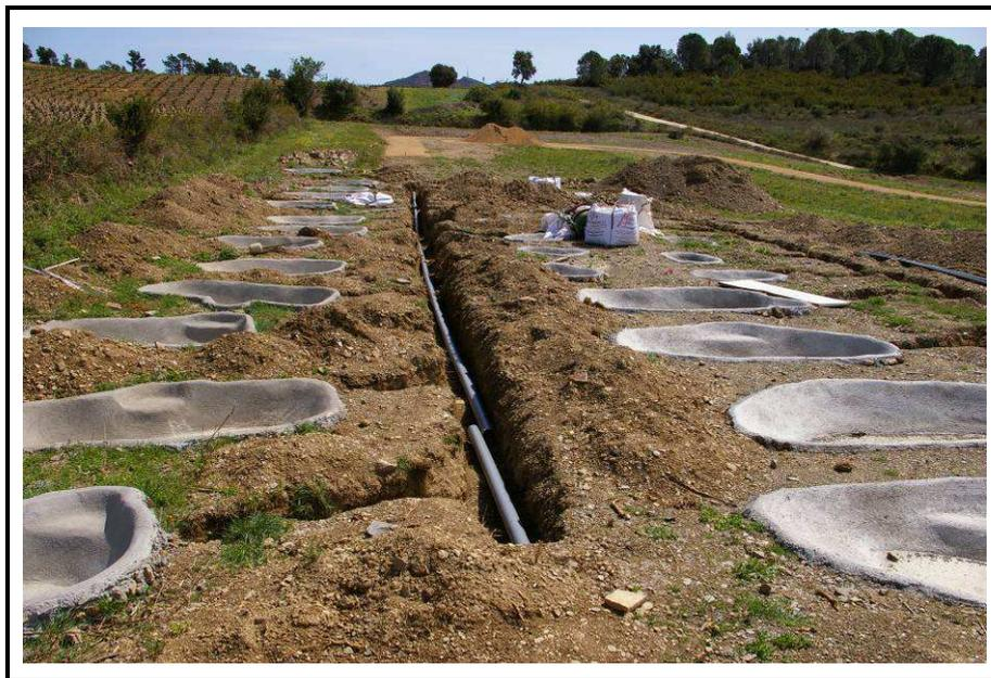
**Figura 12.** Instalación del sistema de desagüe. Fuente: ATA.
