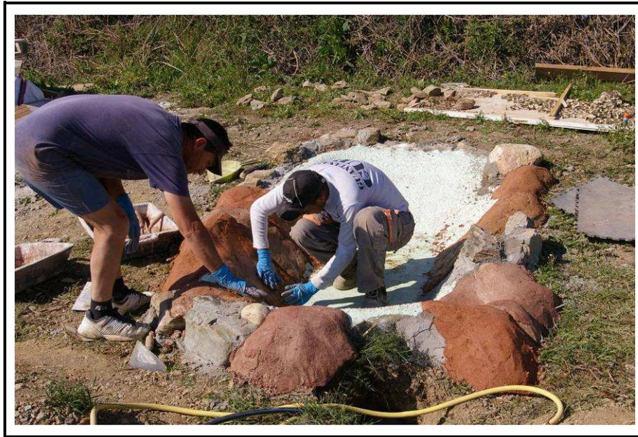
**Figura 11.** Colocación de un revestimiento perimetral que simule la piedra personalizando la pequeña laguna. Fuente: ATA.
