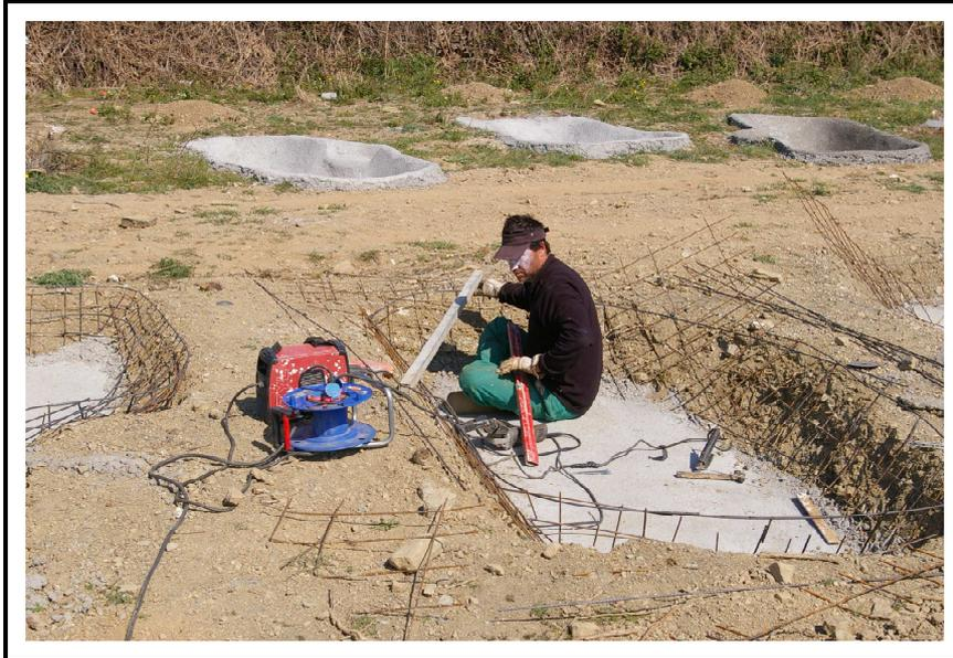
**Figura 7.** Construcción pequeñas lagunas, colocación grava y hierros.
