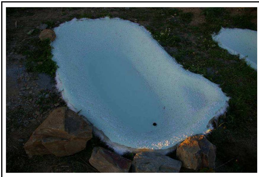
**Figura 10.** Colocación de la pintura poliéster. Fuente: ATA.
