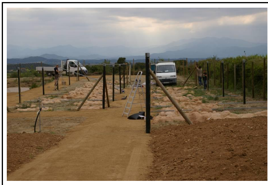
Figura 13. Construcció estructura base de pals de fusta tornejats. Font: ATA.
