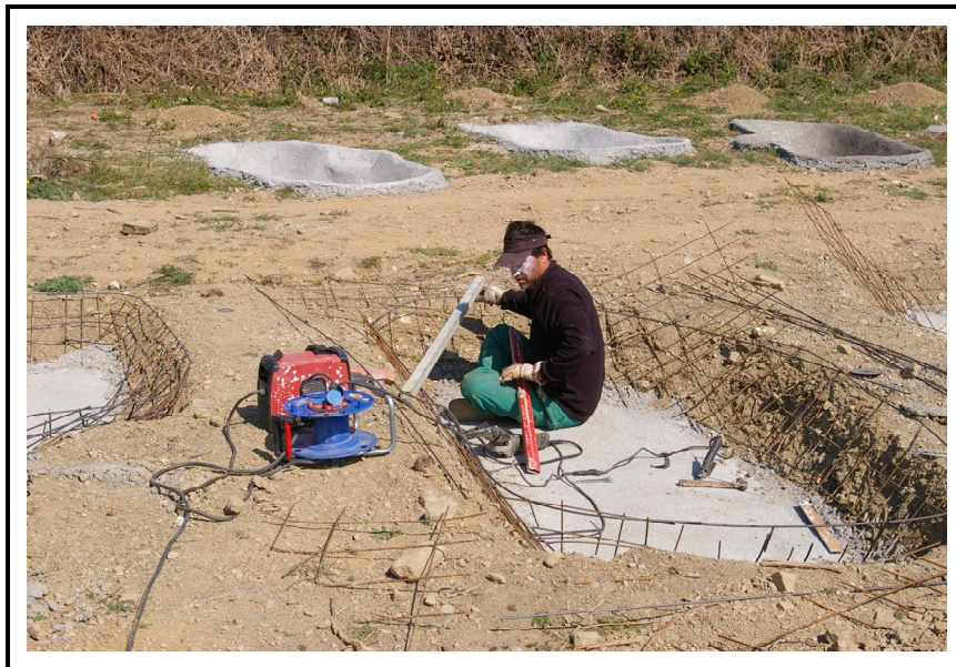
Figura 7. Construcció basses, col·locació grava i ferros. Font: ATA.
