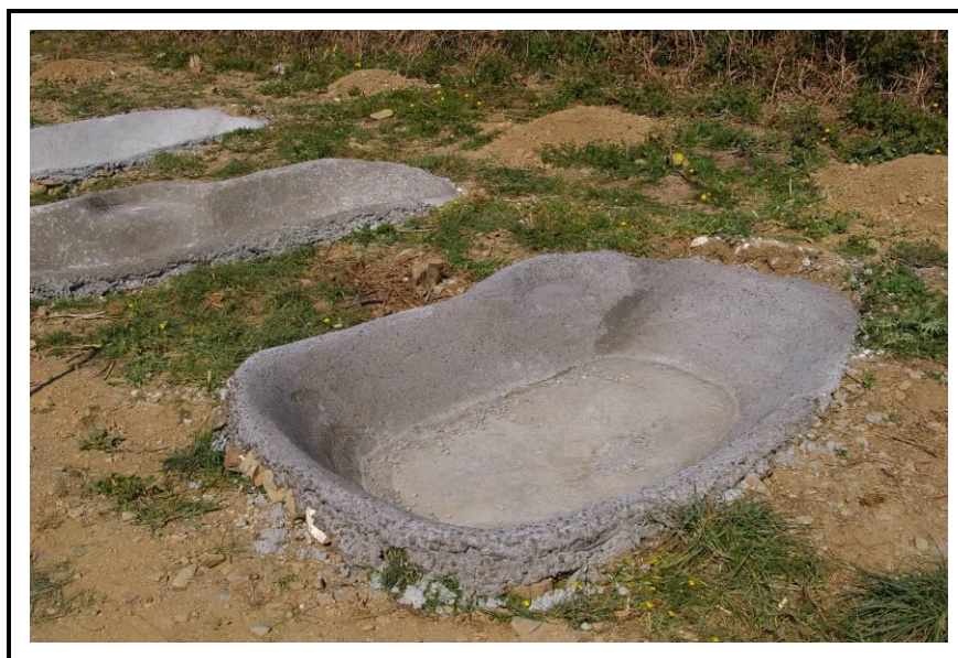
Figura 8. Construcció basses, col·locació formigó terra i parets. Font: ATA.
