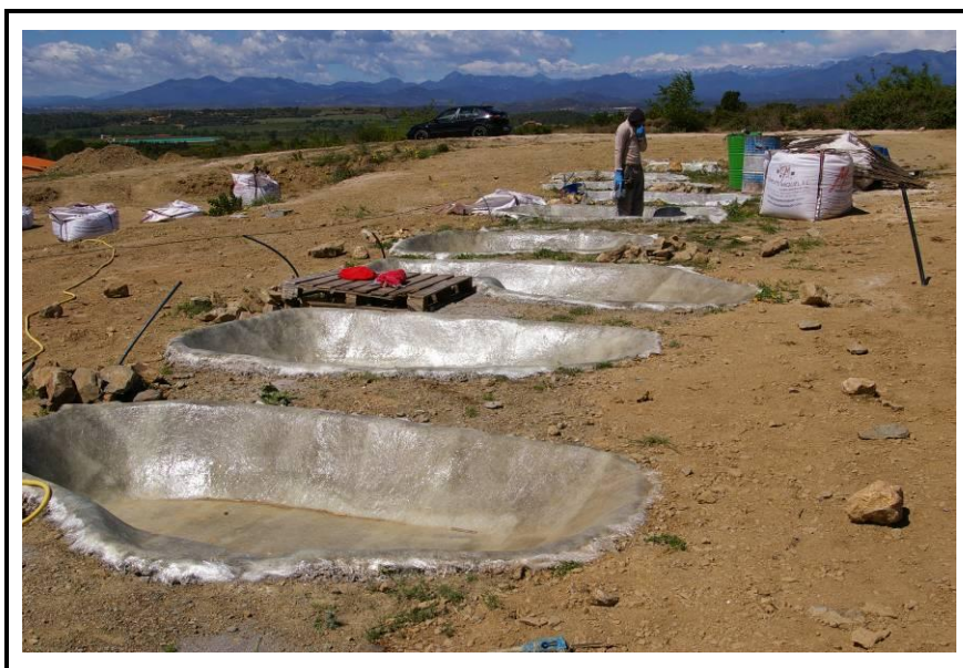
Figura 9. Construcció basses, col·locació de poliester. Font: ATA.
