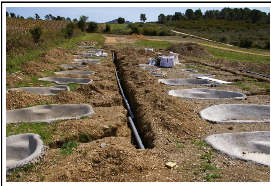
Figura 12. Instal·lació del sistema de desaigües. Font: ATA.
