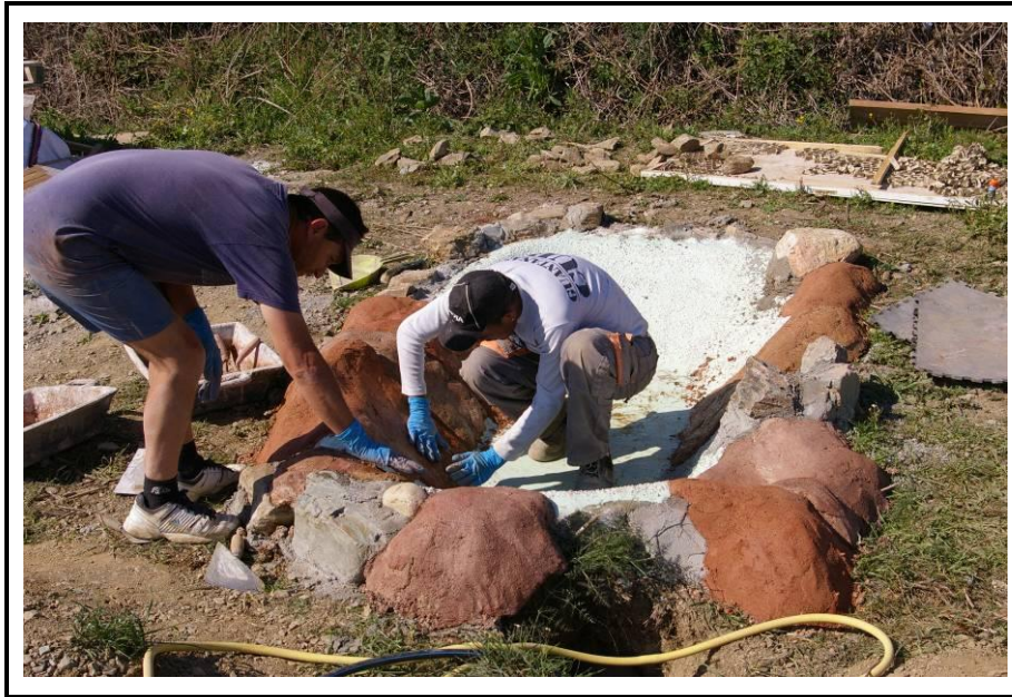
Figura 11. Col·locació d'un revestiment perimetral que simuli la pedra buscant la personalització de la bassa. Font: ATA.
